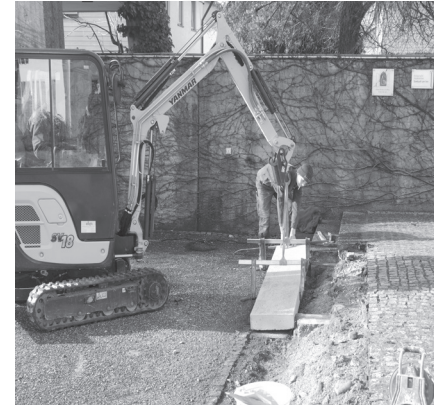
Die defekten Stufen werden ausgetauscht (Foto: Christian Muschler)
