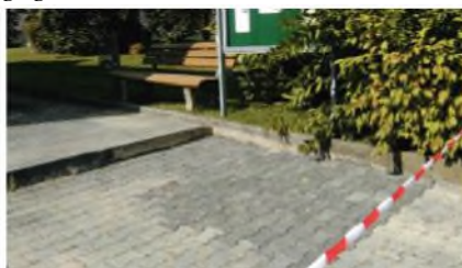
25.9.18 Die kleine Rampe am Schaukasten wird entfernt, das Pflaster dort neu verlegt.
