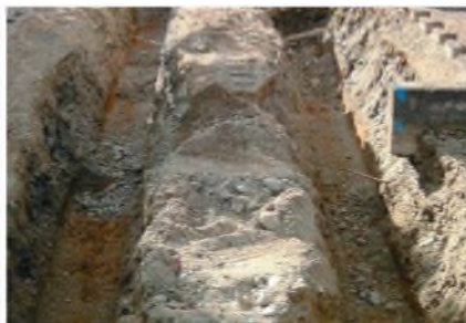
24.9.18 Die alte Rampe ist entfernt. Für die neue wird ein Fundament gegraben.
