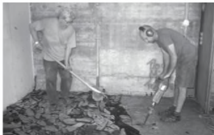
Der Raum bei der Entkernung
