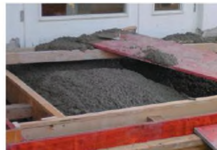
26.9.18 Die Treppe und der untere Teil der Rampe werden betoniert; der mittlere Teil folgt am 2.10.
